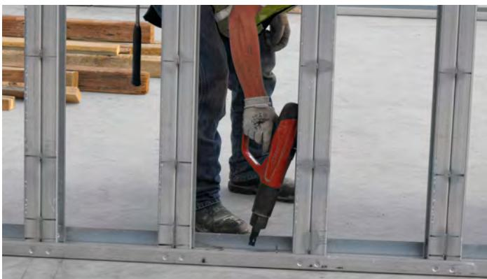
Las herramientas accionadas por pólvora son herramientas impulsadas por una fuerza explosiva que impulsa o descarga un dispositivo de sujeción. La energía proviene de un polvo explosivo que es detonado por un detonador.
