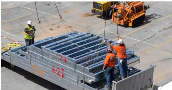
El aparejamiento es el proceso de preparación de cargas de materiales para levantar y mover equipos pesados, como grúas y
